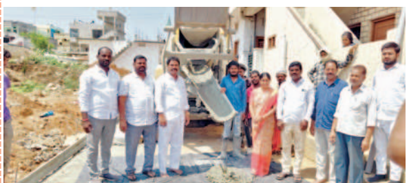
రోడ్డు పనులను పరిశీలిస్తున్న మున్సిపల్ చైర్మన్ దుర్గపూర్గా అశోక్‌గౌడ్
